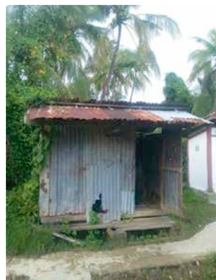
Die alte Toilette neben der Schule
