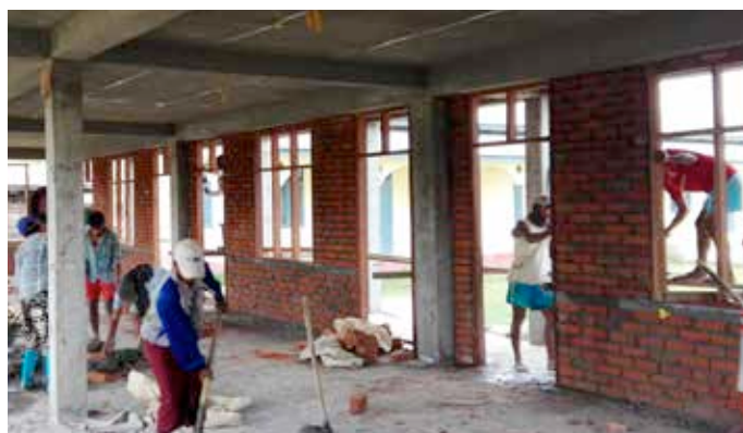
Ausmauern des Erdgeschosses und setzen von Türzargen
