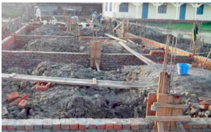
Das Herstellen der Fundamente und des Gebäudesockels
