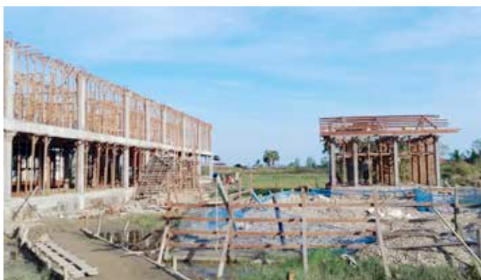
Das Schulgebäude bis 1.OG und die neuen WC's
