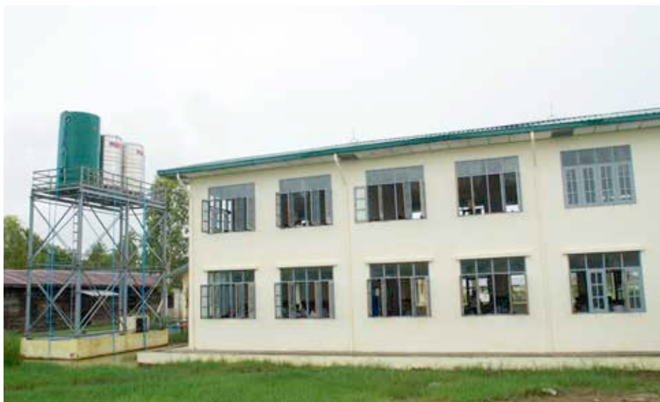
Die neue Wasserversorgung garantiert sauberes Trinkwasser für Schule und Dorf
