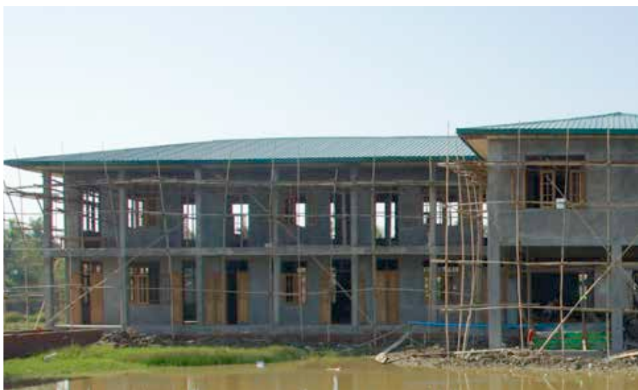
Die fertig verputzte Schule kurz vor den Anstricharbeiten im Februar 2016
